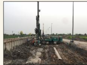
ก่อสร้างช่วงกลางวัน
